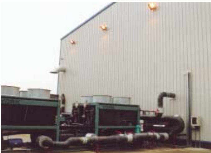
Zwei York Mehrfunktions-Wärmepumpen/Kältemaschinen sorgen für eine Kalt- (zwischen 4 °C und 20 °C) und Warmwasserversorgung (zwischen 20 °C und 60 °C) der Testgeräte
