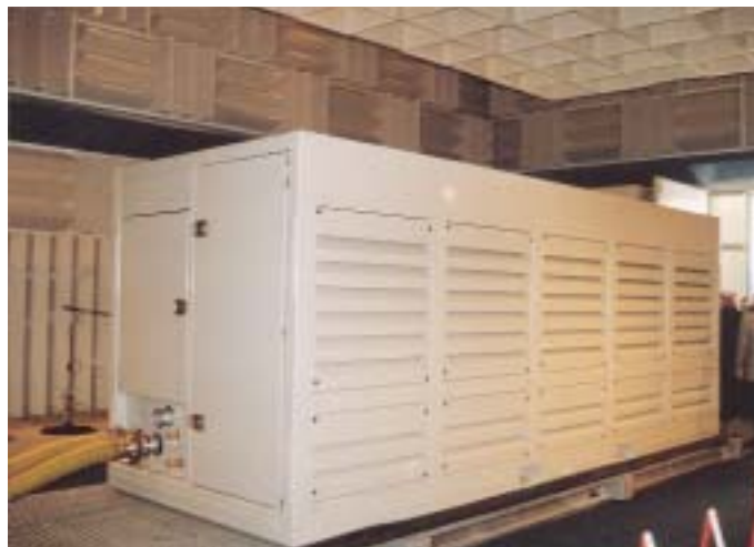
Zwei York Mehrfunktions-Wärmepumpen/Kältemaschinen sorgen für eine Kalt- (zwischen 4 °C und 20 °C) und Warmwasserversorgung (zwischen 20 °C und 60 °C) der Testgeräte
