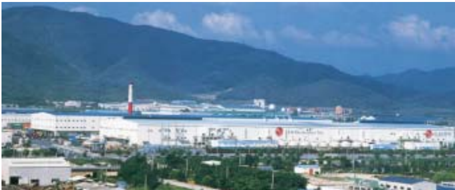
Im größten LG-Werk in Changwon bestehen derzeit Produktionskapazitäten für 5 Mio. Klimageräte/Jahr
