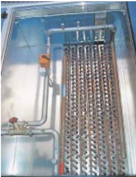
Bild 2 Wärmeaustauscher im Einbauzustand
