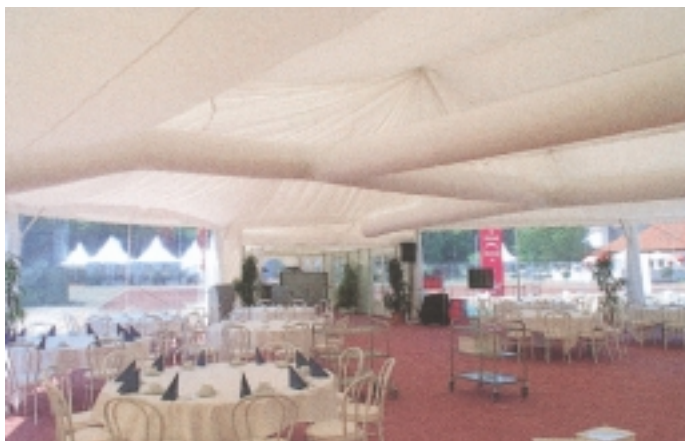
CRS-Geräte im Einsatz: Bei dieser Luftführung ohne Zugerscheinungen ließen es sich die Gäste beim Formel1-Grand-Prix am Hockenheim im vollklimatisierten VIP-Zelt der Telekom schmecken
