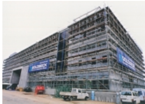
Hier entsteht der neue Landis & Staefa-Hauptsitz in Frankfurt
