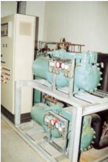
Kaltwassersystem mit 2 Bitzer-Schraubenverdichtersätzen, 2 \times 126 \text{ kW} bei t_0 = 0 \text{ °C}/t_c = 45 \text{ °C} , daneben ein 5000 Liter Pufferspeicher und die Pumpenstation
