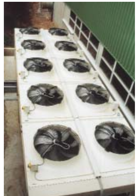
An der Hallenaußenwand in Bodenaufstellung einer der Axialverflüssiger des Fabrikates Alfa Laval
