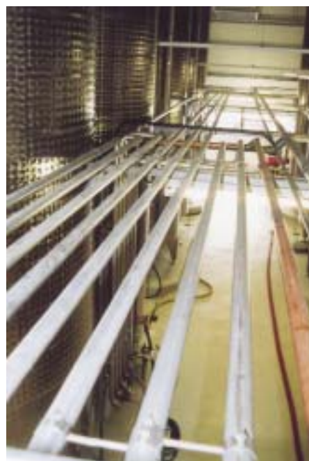
Das sind keine Orgelpfeifen sondern Tanks. Links Kallstadt, rechts Alzey, in der Mitte eine Detailansicht zur Rohrleitungsführung Kältemittel/Wasser. Fruchtige und aromareiche Weine benötigen eine Vergärung bei 18 °C und tiefer. Bei der Kältemitteldirektverdampfung wird das Kältemittel direkt in den Doppelmantel eingespritzt bzw. in die Edelstahl-Wärmetauscherplatten
