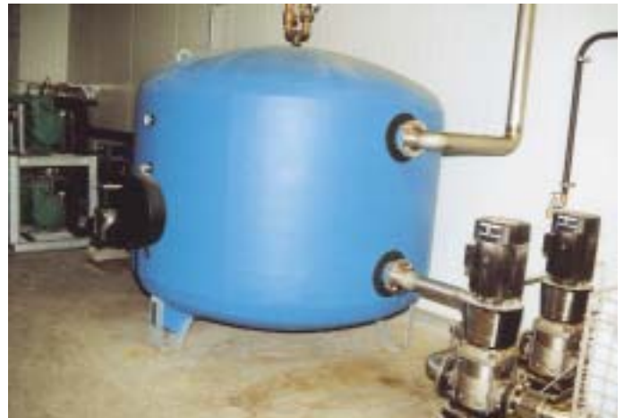
Kaltwassersystem mit 2 Bitzer-Schraubenverdichtersätzen, 2 \times 126 \text{ kW} bei t_0 = 0 \text{ °C}/t_c = 45 \text{ °C} , daneben ein 5000 Liter Pufferspeicher und die Pumpenstation
