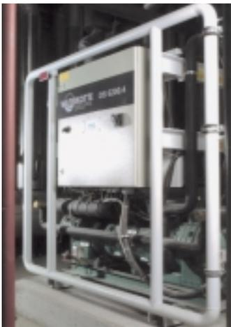
Je nach Leistung sind die Kältesätze mit Scroll-, Kolben- oder Schraubenverdichter ausgerüstet
