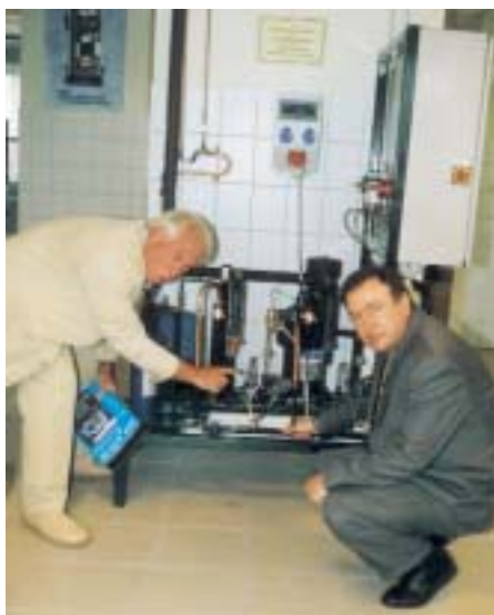
Für die Simulation von Kühl- und Tiefkühlraumtemperaturen hat die Firma Copeland eine Verbundanlage mit zwei Scrollverdichtern gesponsert. Pál Réti von ALFACO KFT (lks.) und Schulleiter Péter Faludy (r.) erklären hier die Druck- und Meßeinrichtungen
