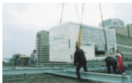
Installation des 5,5 Tonnen schweren Airwell-Kaltwassersatzes
