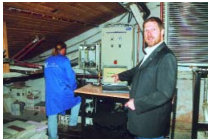
Hier ist der Beweis, HKT-Goeldner-Firmenchef Karl Huber zeigt es: FU-Drehzahlregelung für den Teillastbetrieb bis hinunter auf 20 Hz
