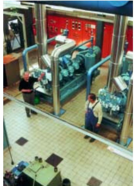
Eindrücke aus einem der Tiefkühlager, an der Decke sichtbar eine Kanalluftführung, sowie aus dem Maschinenraum. Im linken Bildausschnitt zwei der noch vorhandenen Borsig-Verdichter TNS 3215 aus dem Baujahr 1965, rechts die neuen zweistufigen Grasso-Verdichter der Type RC 9312E
