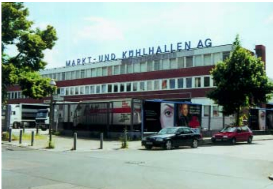
Bild 1 Kühlhaus der MUK AG in Berlin-Neukölln
