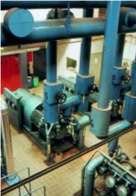
Eindrücke aus einem der Tiefkühlager, an der Decke sichtbar eine Kanalluftführung, sowie aus dem Maschinenraum. Im linken Bildausschnitt zwei der noch vorhandenen Borsig-Verdichter TNS 3215 aus dem Baujahr 1965, rechts die neuen zweistufigen Grasso-Verdichter der Type RC 9312E
