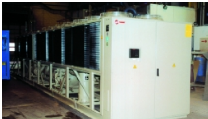
Die größten komplett gefertigten Aggregate sind luftgekühlte Flüssigkeitskühlsätze mit einer Länge von 14 m
