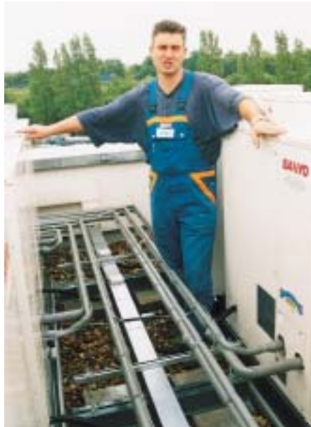
Vorbildliche Installation der Kältemittelleitungen, Steffen Pomsel, bauleitender Obermonteur bei Strang + Bähre (Braunschweig) hat schon 21 Sanyo-ECO-Multisplitanlagen, objektbezogen mit zwischen 16 und 85 Innengeräten, montiert
