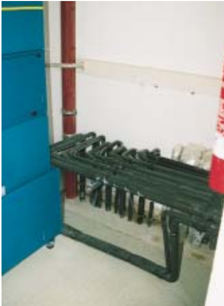
Vorbildliche Installation der Kältemittelleitungen, Steffen Pomsel, bauleitender Obermonteur bei Strang + Bähre (Braunschweig) hat schon 21 Sanyo-ECO-Multisplitanlagen, objektbezogen mit zwischen 16 und 85 Innengeräten, montiert
