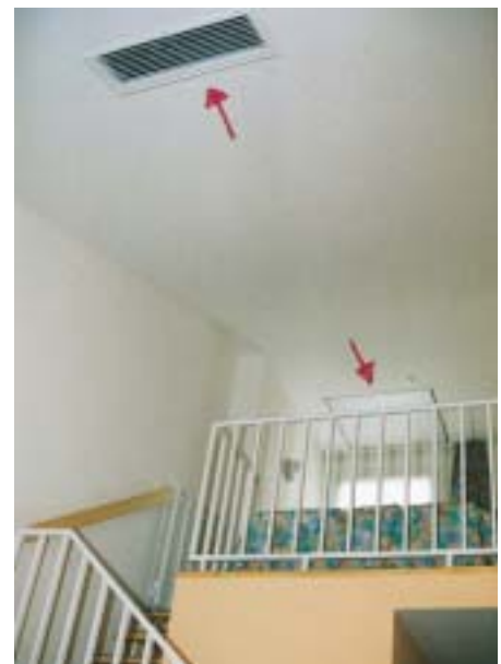
Eltern mit zwei Kindern übernachten in Galerie-Zimmern über zwei Etagen. Die Raumluft wird über Schattenfugen vom Gerät im oberen Galeriebereich wieder angesaugt
