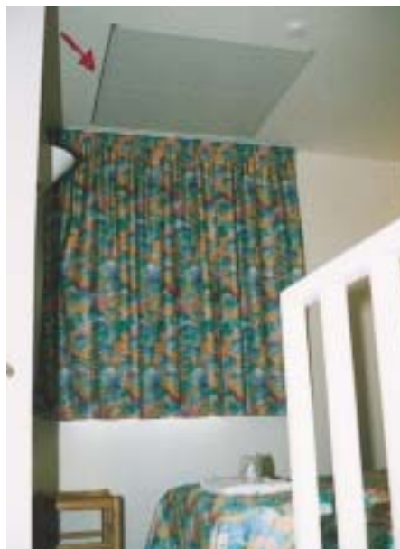
Eltern mit zwei Kindern übernachten in Galerie-Zimmern über zwei Etagen. Die Raumluft wird über Schattenfugen vom Gerät im oberen Galeriebereich wieder angesaugt
