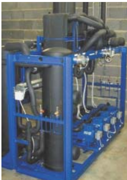
Bild 6 CO 2 -Tiefkühlverbundsatz
