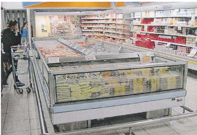
Teile der Kühleinrichtungen bei terranova. Links 7 m doppelseitige Tiefkühlinsel, rechts 7 m Molkereiproduktekühlregal
