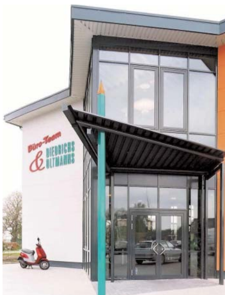
Das neue Gebäude von Büro-Team Diedrichs & Oltmanns wird komplett mit einem modernen VRF-System beheizt und gekühlt
