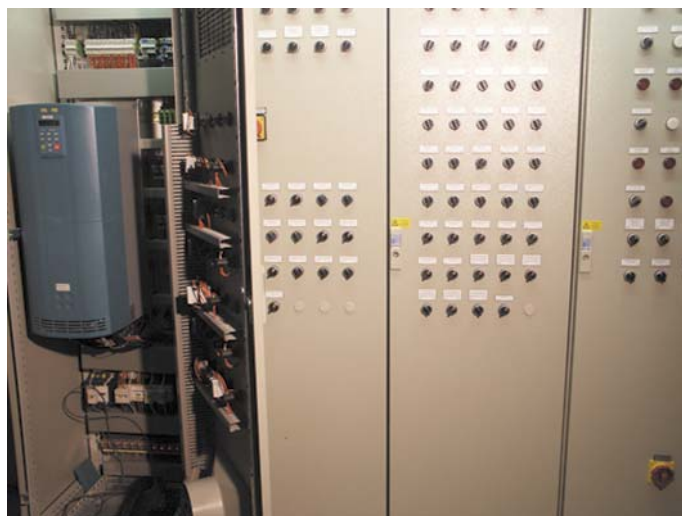
tocata Software im Computerschaltkasten und der Kimo-Frequenzumrichter im Schaltschrank eingebaut
