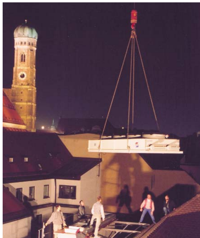
Verbundanlage mit Dorin-Verdichtern zum Zeitpunkt von Anlieferung und Montage
