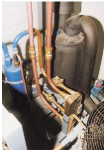
Die Wärmerückgewinnung der Verflüssigerwärme über Plattenwärmetauscher dient hier für die Warmwasserversorgung des Bodenunterfrigungsschutzes des Tiefkühlagers
