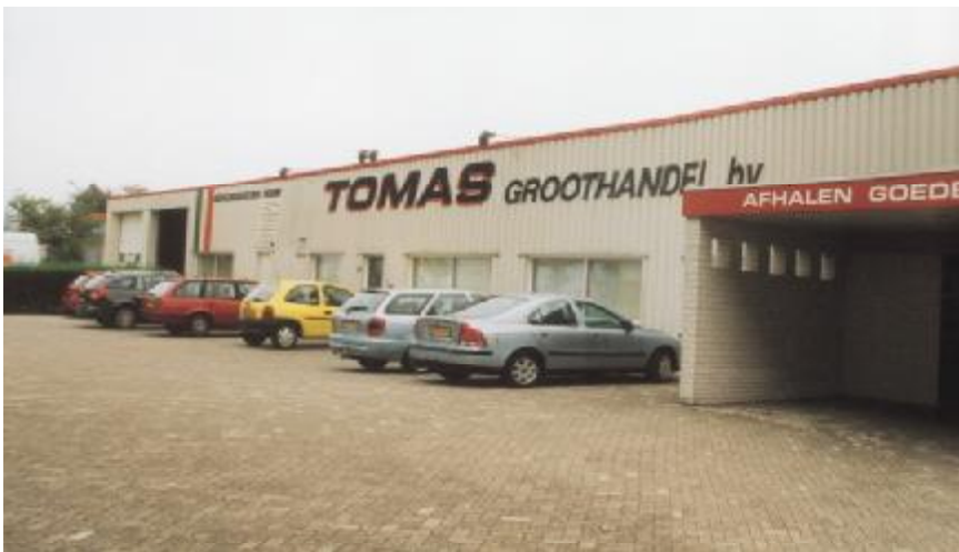
Tomas Bakkerij Groothandel Stadskanaal nahm für sein Tiefkühlhaus-Neubau sowohl die STIMEK-Förderung als auch die EIA-Steuerückvergütung in Anspruch
