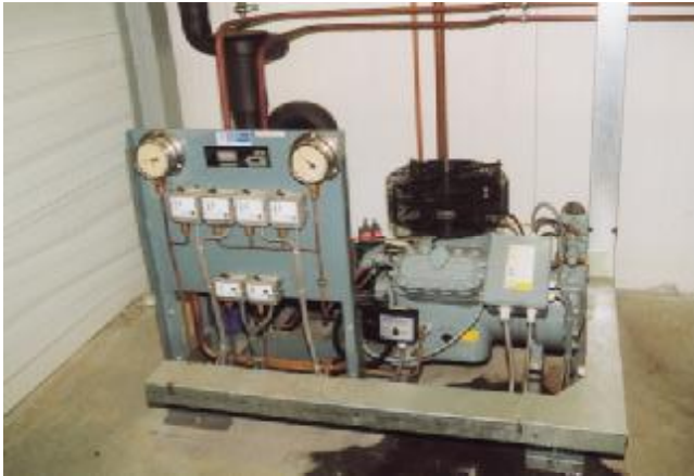
Verdichter (DWM/Copeland) für das Tiefkühlager, Sammler ohne zusätzliche Druckerhöhungsmaßnahmen unter der Decke des Maschinenraumes plaziert
