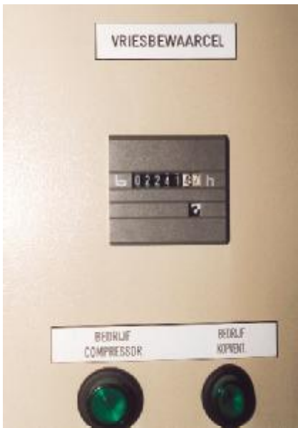
Optimale Energieeffizienz im kWh-Verbrauch. Die Betriebsstundenzähler (2241 h für das Tiefkühlager, 1806 kWh für die Schleuse) liefern den Beweis: Durchschnittliche Laufzeit von 3,44 h/24h (Tiefkühlager) und 4,27 kWh (Schleuse). Effizienter geht's kaum
