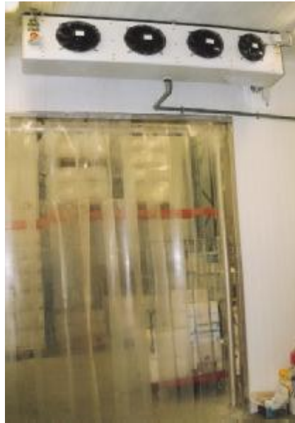
Im Inneren des Tiefkühlagers platzierte Tiefkühlschleuse mit Gabelstapler-Rammschutz. Der oberhalb des Streifenvorhangs angeordnete Ventilatorluftkühler (Fabrikat Küba) dient vorrangig auch der (Luft)Feuchtebindung
