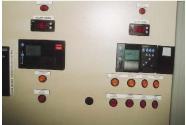
Nach der STIMEK-Industrie-Regelung darf die Eintrittstemperaturdifferenz (DT 1) am Luftkühler/Tiefkühlager (hier Fabrikat Küba) nicht mehr als 6 K betragen, am Verflüssiger 10 K. Hierzu ist die ADAP-Kool-Regelung von Danfoss sehr hilfreich
