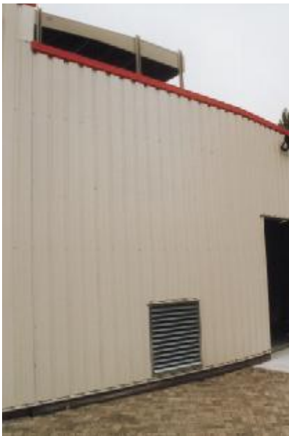
Dachaufstellung des luftgekühlten Verflüssigers (Fabrikat Küba). Darunter ist das Luftansauggitter für die Verflüssigungseinheit der Tiefkühlschleuse sichtbar. Auf dem rechten Bild ist von einem der Ventilatorluftkühler der Tauwasserablauf-/auslaufstutzen (im Winter elektrisch beheizt) zum Gulli sichtbar
