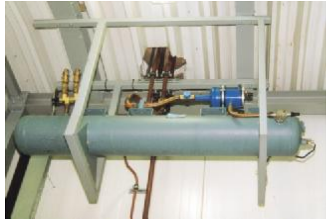
Verdichter (DWM/Copeland) für das Tiefkühlager, Sammler ohne zusätzliche Druckerhöhungsmaßnahmen unter der Decke des Maschinenraumes plaziert
