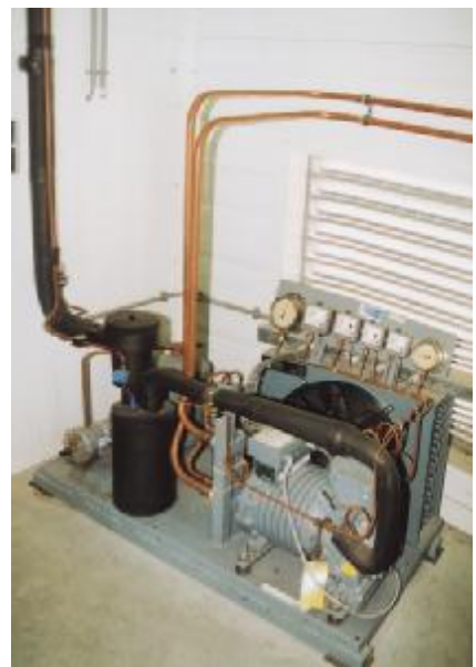
Separate Verflüssigungseinheit (DWM/Copeland) für die Tiefkühlschleuse
