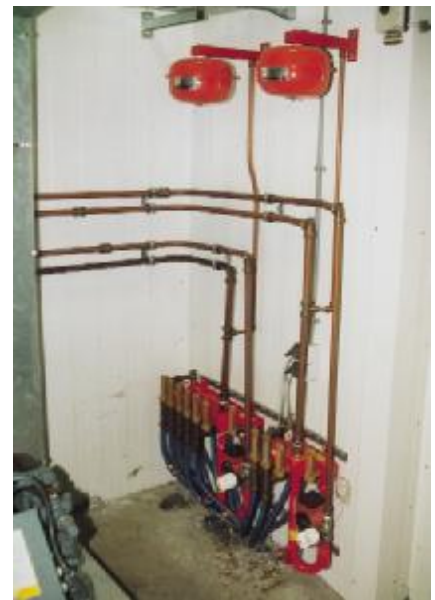
Die Wärmerückgewinnung der Verflüssigerwärme über Plattenwärmetauscher dient hier für die Warmwasserversorgung des Bodenunterfrigungsschutzes des Tiefkühlagers
