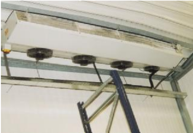
Nach der STIMEK-Industrie-Regelung darf die Eintrittstemperaturdifferenz (DT 1) am Luftkühler/Tiefkühlager (hier Fabrikat Küba) nicht mehr als 6 K betragen, am Verflüssiger 10 K. Hierzu ist die ADAP-Kool-Regelung von Danfoss sehr hilfreich
