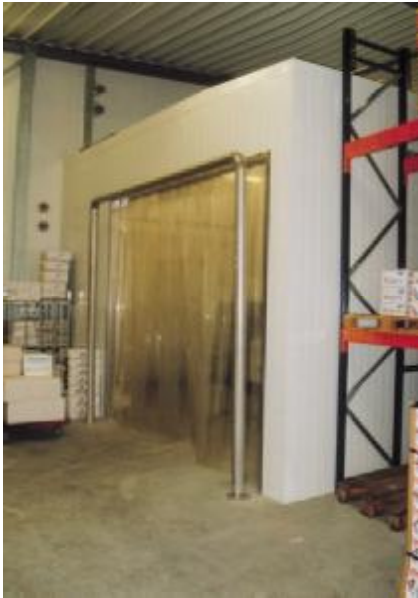
Im Inneren des Tiefkühlagers platzierte Tiefkühlschleuse mit Gabelstapler-Rammschutz. Der oberhalb des Streifenvorhangs angeordnete Ventilatorluftkühler (Fabrikat Küba) dient vorrangig auch der (Luft)Feuchtebindung
