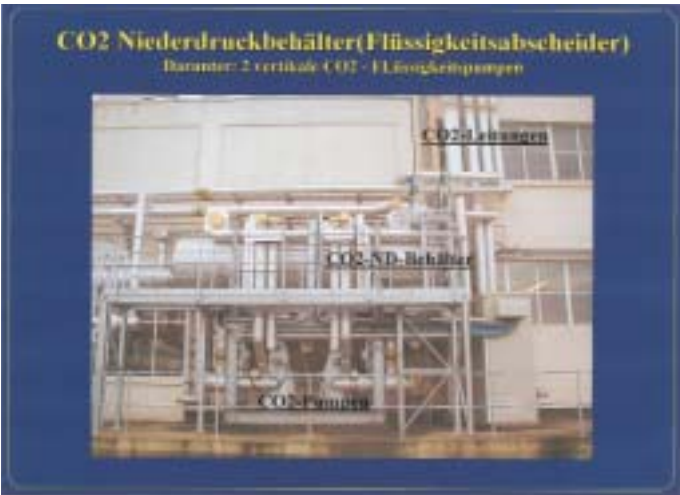
Bild 11 Ansicht eines installierten kompletten CO 2 -Rezirkulationssystems
