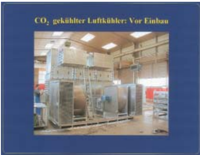
Bild 14 Ansicht eines Luftkühlers vor dem Einbau
