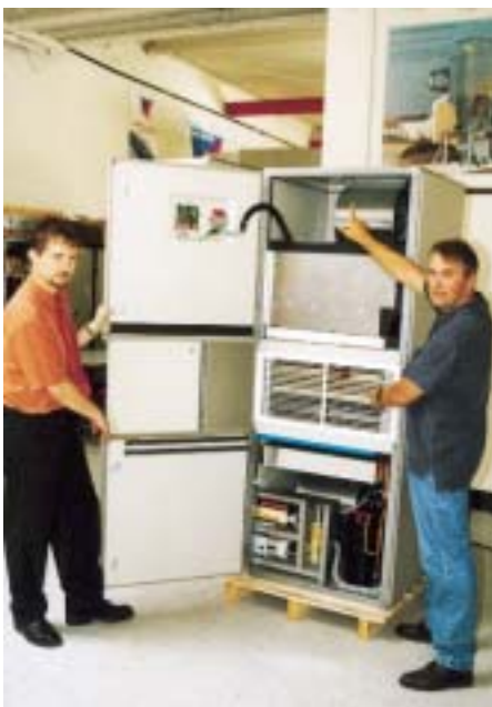
AL-KO-Klimasäule AS mit integrierter Kälteanlage als Umluftkühlgerät, Luftaustritt oben
