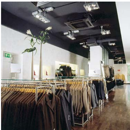
Bei Wormland in Hamburg wurden Architektur und Klimatechnik optisch ansprechend kombiniert
