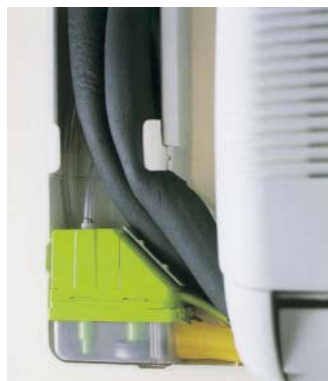
Einbau der Mini Green-Kondensatpumpe von Aspen
