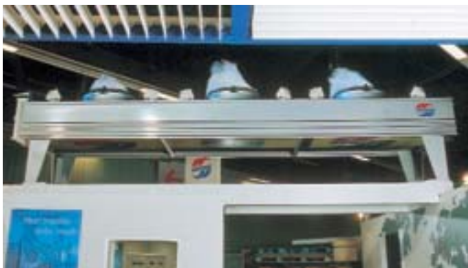
Güntner-Verflüssiger GVS mit selbsttragendem Gehäuse in Dachaufstellung
