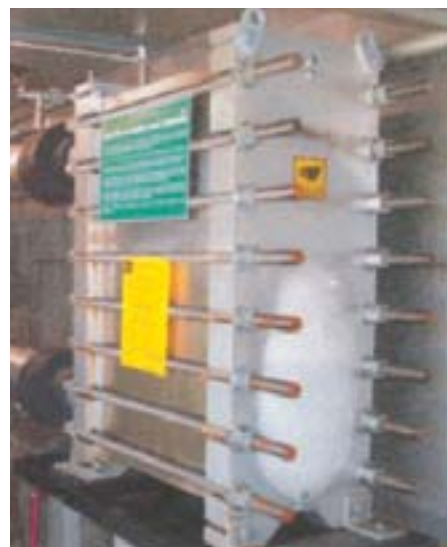
\text{CO}_2 - \text{NH}_3 -Wärmeübertrager von Alfa Laval in einer Anlage von York für 380 kW
