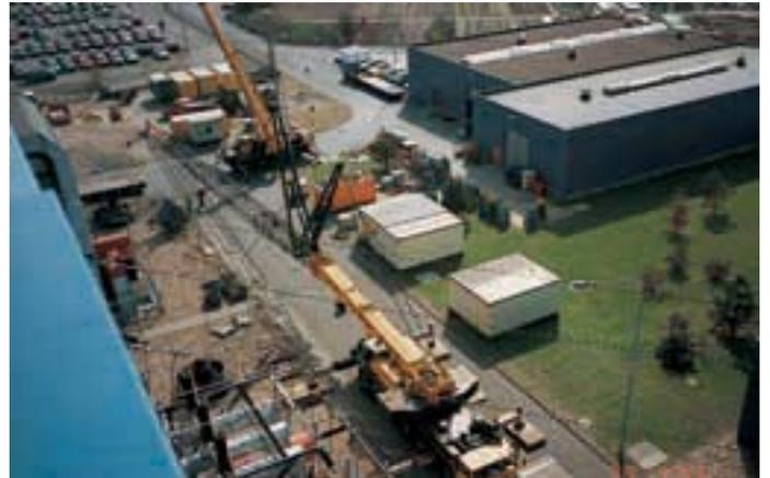
1993, Kraftwerk Wolfsburg. Vorbereitung zur Aufstellung von  $\text{NH}_3$ -Flüssigkeitskühlern mittels Einsatzes eines Krans
