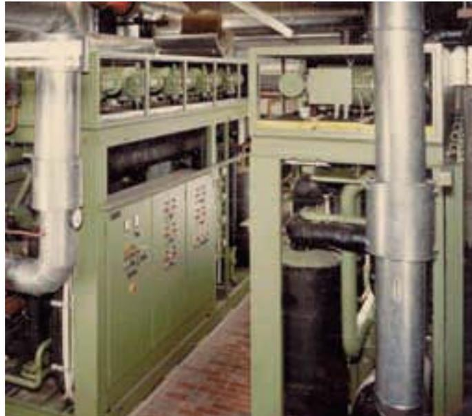
Industriewärmepumpe in Weissach. 2 Kreisläufe mit je 5 Verdichtern vom Typ HSK7061, betrieben mit R 12 (heute R 134a) bei  $t_o = 0/t_c = 70$  °C
