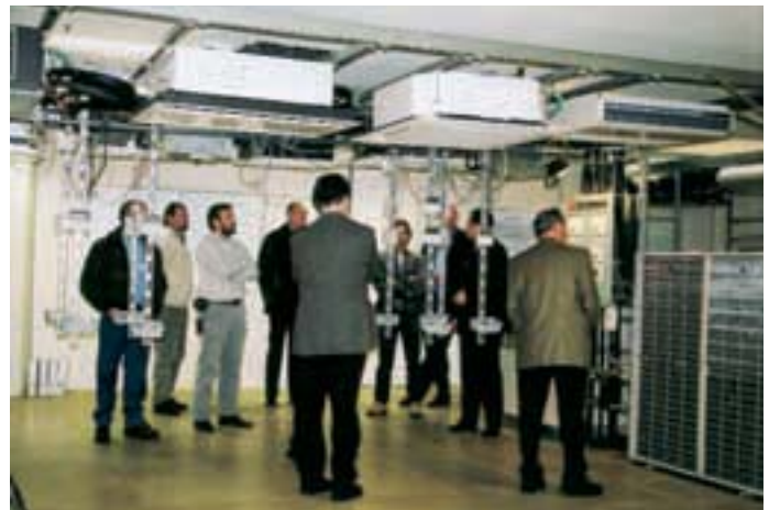
Die Praxis wird Seminarteilnehmern an der Stulz eigenen Trainingsanlage demonstriert
