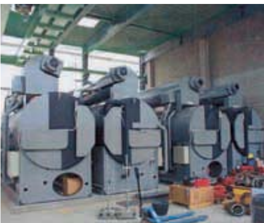
Eindrücke vom Aufbau der neuen Kältezentrale für den erweiterten Flughafen München
