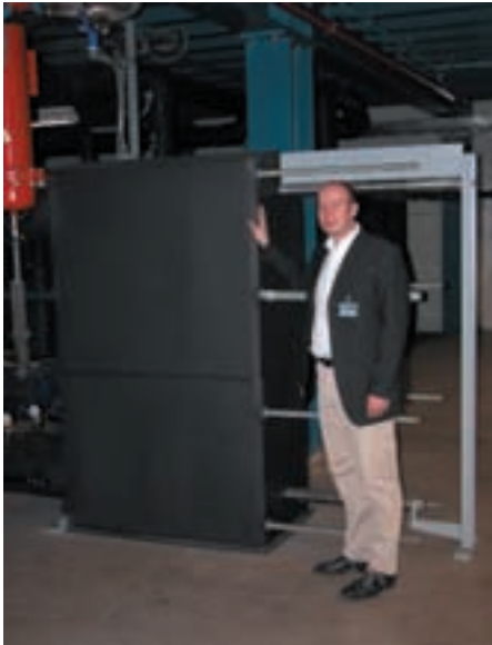
Michael Escher neben dem beachtlichen Plattenwärmeübertrager (derzeit 1,6 MW) zwischen Rückkühler und Kaltwassersatz beim Automobilzulieferer Karmann in Osnabrück – bei diesem Kunden ist die absolute Prozeßsicherheit oberstes Gebot
