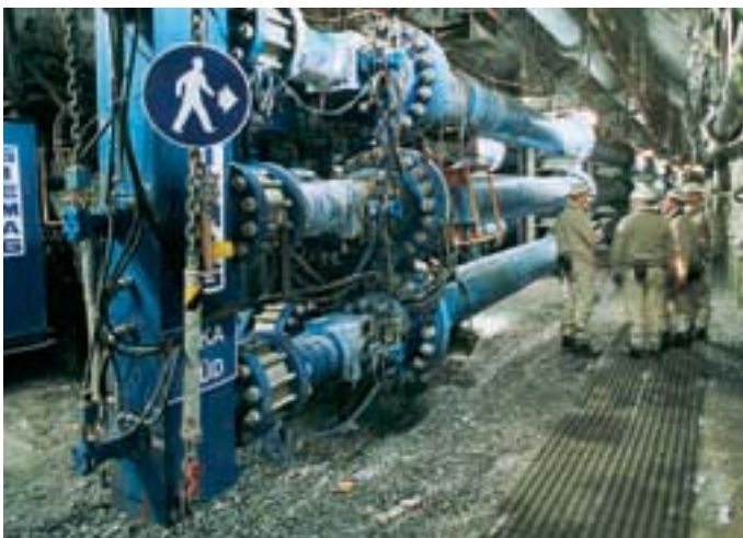
Einer der beiden Dreikammerrohraufgeber unter Tage sowie eine der Pumpenstationen für den Kaltwasserrücklauf
