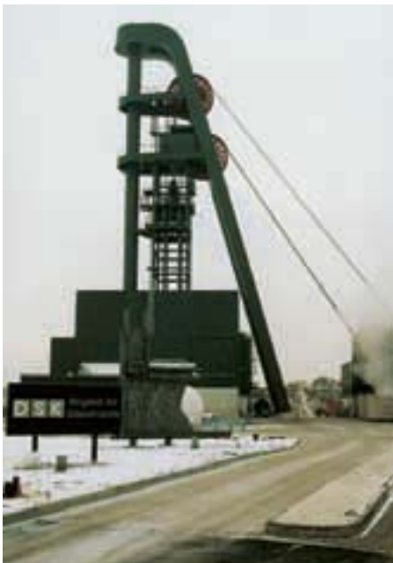
Teilansicht von Schacht „Lerche“. Hier der Förder-turm. Mit dem Großkorb können maximal 2 \times 54 = 108 Leute gleichzeitig eingefahren werden, mit dem kleineren, westlichen Korb auf den zwei Sätzen 53 Personen. Die Fördergeschwindigkeit beträgt 12 m/sec, die Nutzlast 20 t
