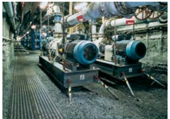
Einer der beiden Dreikammerrohraufgeber unter Tage sowie eine der Pumpenstationen für den Kaltwasserrücklauf
