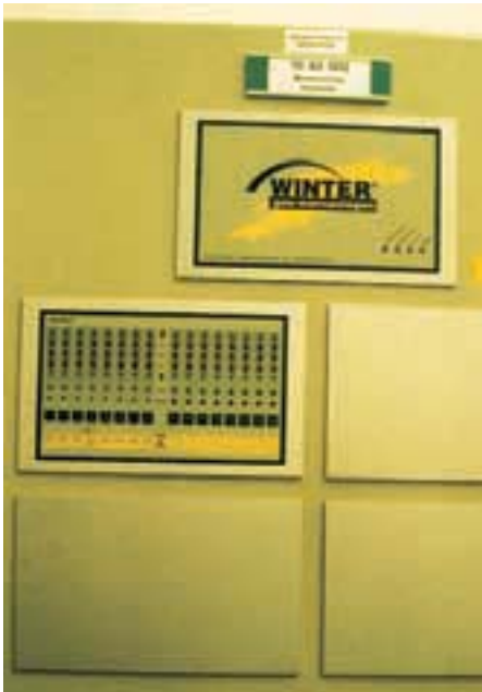
In der Maschinenwarte die Gaswarnanlage für die Früherkennung von R 134a-Kreislauf-Leckagen (gemäß Stand der Technik)
