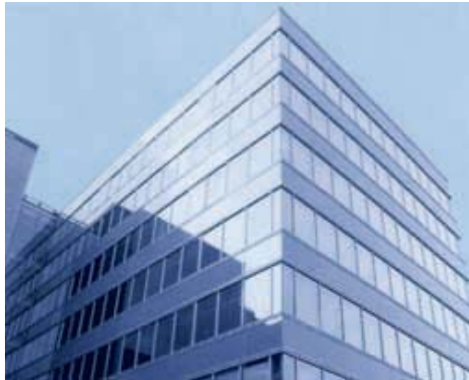
Bild 7 Teilansicht des Neckermann-Rechenzentrums in Frankfurt/Main. Mit sanierter Fassade für den Einbau von Fassaden-Lüftungsgeräten
