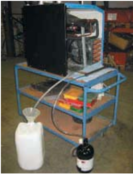
Bilder 2a–c Spülen der Kälteanlage mit einer Handpumpe
