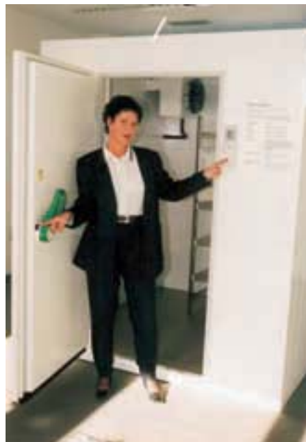
Es geht nicht nur um die mit Cyclopentan geschäumte Tür, auf das gesamte Türelement mit integriertem Druckausgleichsventil, Feuchtraumlampe und Thermometer kommt es an. Doris Klaubert, Mitarbeiterin Werbung/Messen, erklärt das hier
