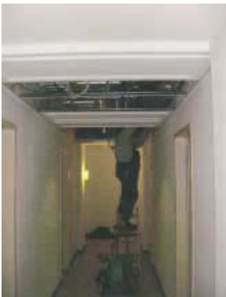
Nicht ganz so einfach gestaltete sich die Rohrleitungsmontage im vorhandenen Zwischendeckenbereich in den Fluren. Oftmals standen Betonstürze, Stahlträger oder alte Wasserleitungen einer direkten Leitungsführung im Wege
