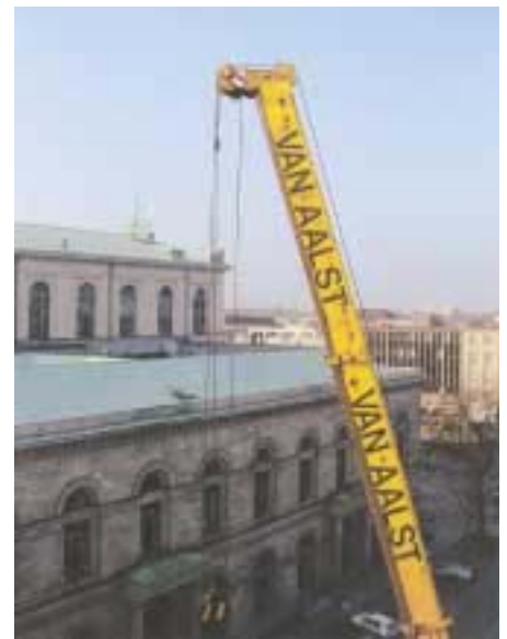
Ein Kran mußte her, um die 4 Außeneinheiten à 34 kW Kälteleistung direkt neben Hannovers Oper auf das Hoteldach zu hieven
