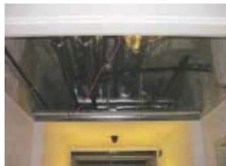
Nicht ganz so einfach gestaltete sich die Rohrleitungsmontage im vorhandenen Zwischendeckenbereich in den Fluren. Oftmals standen Betonstürze, Stahlträger oder alte Wasserleitungen einer direkten Leitungsführung im Wege
