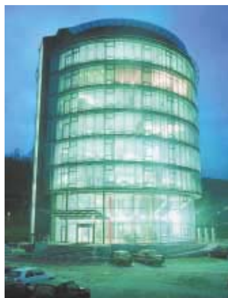
Ein echter Blickfang: Das neue Büro- und Entwicklungszentrum von OWA, ausgestattet mit Klima- und Lüftungstechnik von Trox – es gilt als Demonstrationsobjekt für beide Unternehmen
