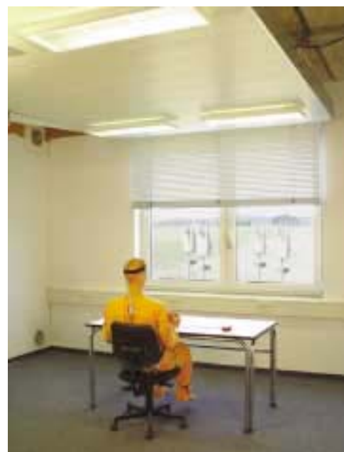
Meßraum „Hybride Lüftung“ im Fraunhofer-Institut für Bauphysik in Holzkirchen mit abgehängtem Klimasegel, aufgesetztem Umluftkühl-/Heizgerät sowie integriertem Lichtsystem
