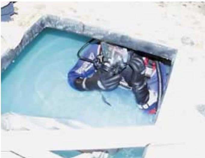
Geschafft und abtauchen durch eine der 0,80 m x 0,80 m Inspektionsöffnungen
