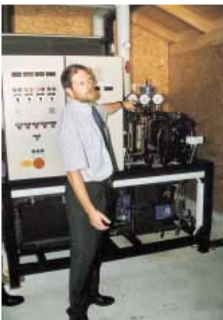
Charly Huber zeigt's: Das ist er! Der Prototyp eines 40 kW Kaltwassersatzes mit 9,1 kg \text{NH}_3/\text{DME} (R 723)-Kältemittel und Kupferrohr-Verrohrung
