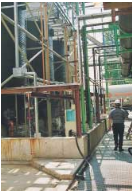
Im Bild zu sehen: Drei hintereinander angeordnete Lagerbehälter (je 40 m 3 Inhalt) für das Spaltprodukt Flußsäure
