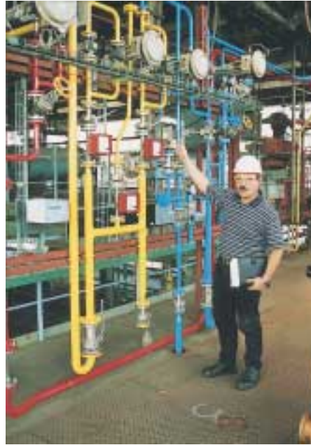
Das Herzstück des Sekundär-Recycling-Verfahrens von Solvay Fluor in Frankfurt-Höchst besteht aus der Hochtemperatur-Spaltkammer, in deren oberen Teil zur „Befuerung“ ein Wasserstoff/Sauerstoffgemisch (linkes und rechtes Bild) zur Erzeugung einer Knallgasflamme hinzugeführt wird. Nähere Erläuterungen hierzu gibt Dipl.-Ing. Martin Selt, Leitung Produktion
