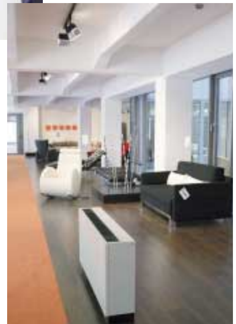
Die Truhengeräte der Anlage fügen sich harmonisch in die moderne Innenarchitektur der Räumlichkeiten ein. Mit moderner Invertertechnik heizt und kühlt das Klimasystem unter anderem Büros und Konferenzraum des Internetproviders Itellium sowie den Showroom des Möbelherstellers Sofabed
