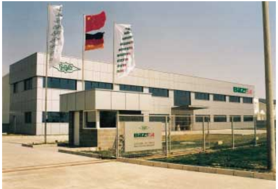
Frontansicht von Bitzer Compressors (Beijing) BCB. Im März 2002 wurde diese Fertigungsstätte semihermetischer Kompaktschraubenverdichter und Aluminium-Hubkolbenverdichter für die Busklimatisierung mit 4800 m 2 in Betrieb genommen und jetzt schon wieder um 5000 m 2 erweitert
