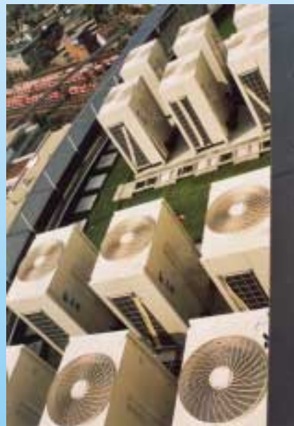
Die erste VRV 2 -Anlage mit R 410A in Europa von Daikin
