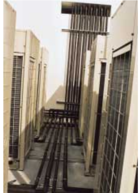
Kältemittelrohrleitungsführung zum Anschluß der Zwischendeckengeräte an die Außengeräte über vertikale begehbare Rohrleitungsschächte. Das ergibt 380 lfm Steigleitung. Dipl.-Ing. Ernst Ege von der Ingenieurgesellschaft Wetzstein aus Herrenberg erläutert dies hier dem Fotografen in einem der Zwischengeschosse
