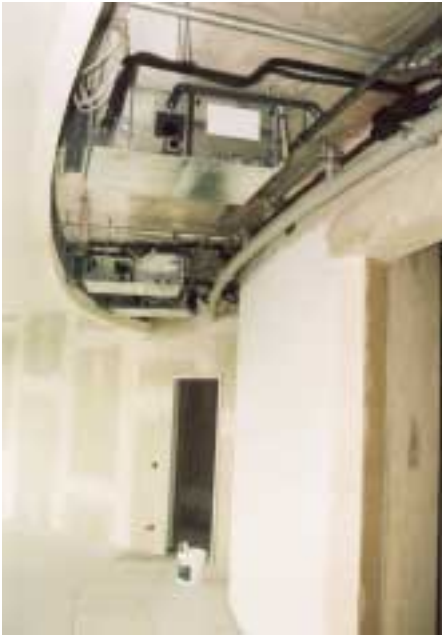
Kältemittelrohrleitungsführung zum Anschluß der Zwischendeckengeräte an die Außengeräte über vertikale begehbare Rohrleitungsschächte. Das ergibt 380 lfm Steigleitung. Dipl.-Ing. Ernst Ege von der Ingenieurgesellschaft Wetzstein aus Herrenberg erläutert dies hier dem Fotografen in einem der Zwischengeschosse
