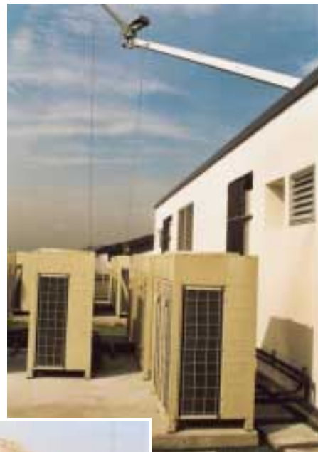
Die erste Daikin VRV 2 -Multisplit-Klimaanlage Europas kühlt in Kürze 21 Büroetagen des Colorado-Towers in Stuttgart-Vaihingen mit vielen Einzelraumregelungen über Kabelfernbedienung
