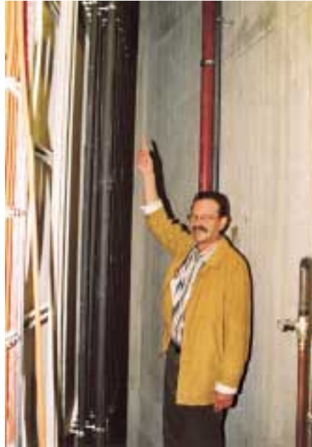
Kältemittelrohrleitungsführung zum Anschluß der Zwischendeckengeräte an die Außengeräte über vertikale begehbare Rohrleitungsschächte. Das ergibt 380 lfm Steigleitung. Dipl.-Ing. Ernst Ege von der Ingenieurgesellschaft Wetzstein aus Herrenberg erläutert dies hier dem Fotografen in einem der Zwischengeschosse
