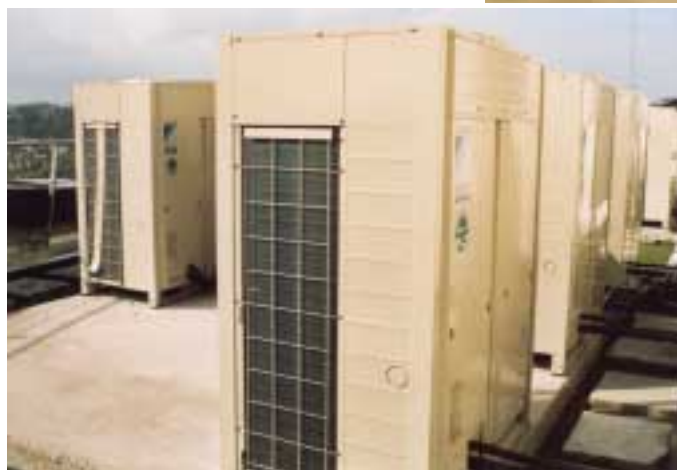
Die erste Daikin VRV 2 -Multisplit-Klimaanlage Europas kühlt in Kürze 21 Büroetagen des Colorado-Towers in Stuttgart-Vaihingen mit vielen Einzelraumregelungen über Kabelfernbedienung
