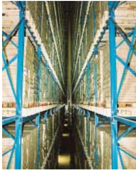
Größenverhältnisse. Zum Vergleich auf gleichem Niveau in ca. 20 Meter Höhe fotografiert. Das 28 m hohe vollautomatisch zu beschickende Tiefkühlager hat ein Raumvolumen von ca. 200 000 m 3 , ein „bequemer“ Laufgang führt bei – 28 °C Raumtemperatur zu den 6 an jeder Stirnseite des Raumes nebeneinander angeordneten Ventilatorluftkühlern mit goldlackbeschichteten Lamellen
