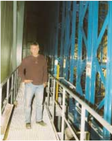
Größenverhältnisse. Zum Vergleich auf gleichem Niveau in ca. 20 Meter Höhe fotografiert. Das 28 m hohe vollautomatisch zu beschickende Tiefkühlager hat ein Raumvolumen von ca. 200 000 m 3 , ein „bequemer“ Laufgang führt bei – 28 °C Raumtemperatur zu den 6 an jeder Stirnseite des Raumes nebeneinander angeordneten Ventilatorluftkühlern mit goldlackbeschichteten Lamellen
