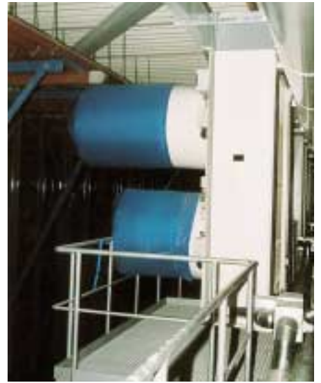
Größenverhältnisse. Zum Vergleich auf gleichem Niveau in ca. 20 Meter Höhe fotografiert. Das 28 m hohe vollautomatisch zu beschickende Tiefkühlager hat ein Raumvolumen von ca. 200 000 m 3 , ein „bequemer“ Laufgang führt bei – 28 °C Raumtemperatur zu den 6 an jeder Stirnseite des Raumes nebeneinander angeordneten Ventilatorluftkühlern mit goldlackbeschichteten Lamellen
