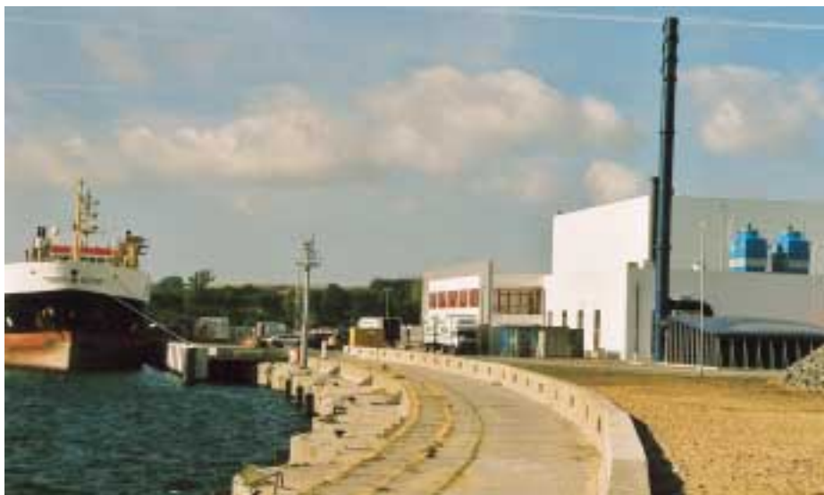
Teilansicht des neuen Fischverarbeitungszentrums der Euro-Baltic auf 12 Hektar aufgespültem Meeresboden im Bereich der Nordmole des Fährhafens Sassnitz. Am Kai ein Schiff der P & P-Flotte bei der Entladung von auf See gefrostetem Fisch
