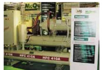
Größere Dimensionen haben die wassergekühlten Flüssigkeitskühler von **McQuay** aus Italien mit einem oder zwei Verdichtern für Leistungen bis 1900 kW auf der Grundlage von Einwellenschraubenverdichtern mit stufenloser Regelung. Bemerkenswert ist dabei die Verwendung von R 410A, womit nicht nur Kompaktheit erreicht wird, sondern auch sehr gute Energieverbrauchswerte
