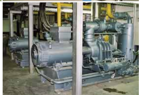
Eindrücke aus dem Maschinenhaus mit Projektleiter Armin Metzger. 7 NH 3 Schraubenverdichter, 4 für die Hochdruckstufe (-11 °C und -4 °C), 3 für den Niederdruckbereich (-45 °C), auf dem Bild rechts oben einer der NH 3 -Abscheider -11 °C, darunter die beiden CO 2 -Abscheider -8 °C und -42 °C
