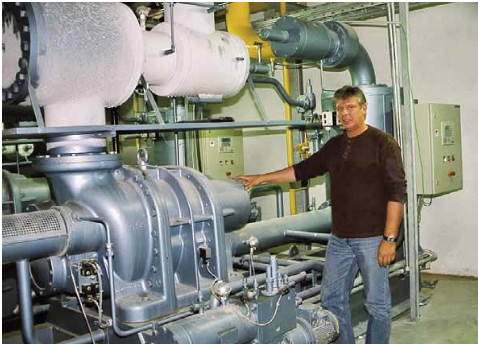
Eindrücke aus dem Maschinenhaus mit Projektleiter Armin Metzger. 7 NH 3 Schraubenverdichter, 4 für die Hochdruckstufe (-11 °C und -4 °C), 3 für den Niederdruckbereich (-45 °C), auf dem Bild rechts oben einer der NH 3 -Abscheider -11 °C, darunter die beiden CO 2 -Abscheider -8 °C und -42 °C
