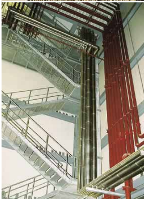
Parallel zu den Treppen vor dem Tiefkühlhaus in die Höhe oder draußen auf Stelzen über das Dach: insgesamt wurden 12 km Kältemittelleitungen sauber verlegt und fachtechnisch bestens isoliert
