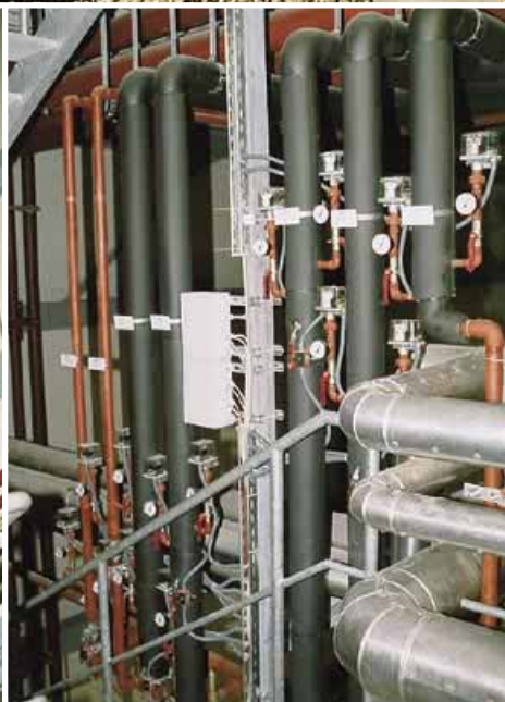
Parallel zu den Treppen vor dem Tiefkühlhaus in die Höhe oder draußen auf Stelzen über das Dach: insgesamt wurden 12 km Kältemittelleitungen sauber verlegt und fachtechnisch bestens isoliert
