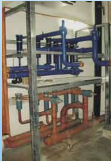
Prause & Partner saniert Airport- Catering in Kuala Lumpur
