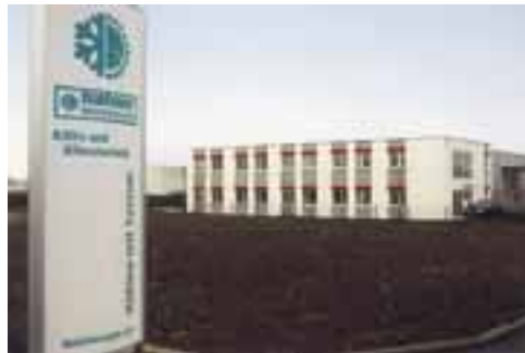
Hauptsitz der neuen Hafner-Muschler GmbH & Co. ist Balingen, wo seit dem 1. Januar 2004 ein neues Verwaltungsgebäude mit angegliederter Fertigungshalle zur Verfügung steht
