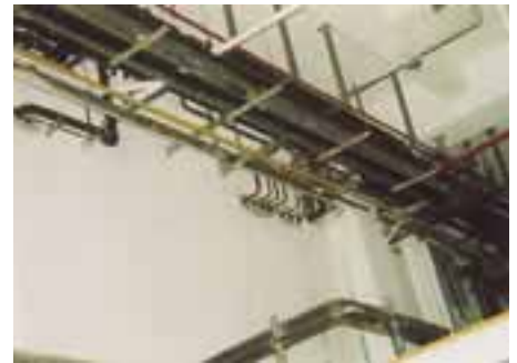
Alte Leitungen wurden durchtrennt. Im Rahmen der Sanierungsarbeiten mussten große Saug- und Flüssigkeitsverteiler im Maschinenraum eingefügt werden. Ab Saugleitungsverteiler „Stahl“, 250 und 200 mm Durchmesser, mehrfache Kupferrohr-Abgänge 133 mm und kleiner
