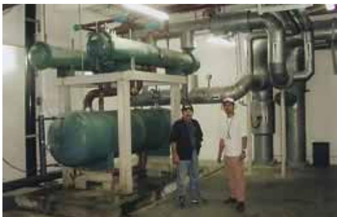
Das linke Bild zeigt die beiden ehemals parallel geschalteten wassergekühlten Verflüssiger und darunter den Sammler in Bypass-Schaltung. Auf dem rechten Bild sind die beiden neuen Verflüssiger mit dazugehörigen Sammlern für die nunmehr getrennten Plus- und Minus-Temperaturkreisläufe zu sehen
