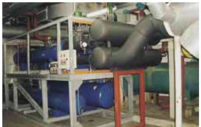
Das linke Bild zeigt die beiden ehemals parallel geschalteten wassergekühlten Verflüssiger und darunter den Sammler in Bypass-Schaltung. Auf dem rechten Bild sind die beiden neuen Verflüssiger mit dazugehörigen Sammlern für die nunmehr getrennten Plus- und Minus-Temperaturkreisläufe zu sehen
