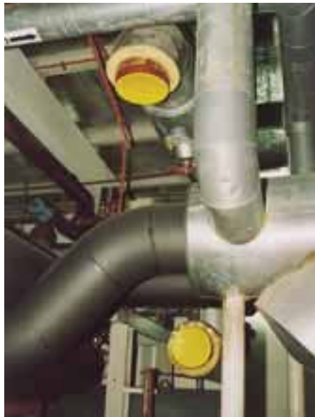
Alte Leitungen wurden durchtrennt. Im Rahmen der Sanierungsarbeiten mussten große Saug- und Flüssigkeitsverteiler im Maschinenraum eingefügt werden. Ab Saugleitungsverteiler „Stahl“, 250 und 200 mm Durchmesser, mehrfache Kupferrohr-Abgänge 133 mm und kleiner
