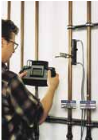
Durchflussmessung mit Mietgeräten
