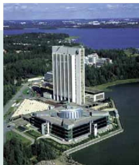
Fortum-Headquarter, erstes mit Thermera gekühltes Gebäude
