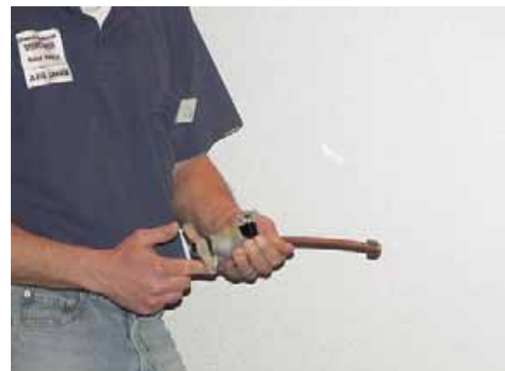
Ein Service-Monteur von Stiebel-Eltron zeigte, wie „einfach“ eine kältemittelführende Leitung bearbeitet, verlegt und angeschlossen wird
